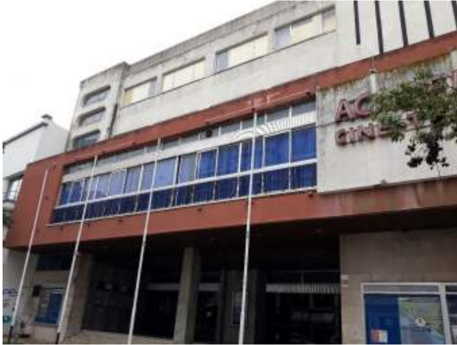
5 – Fachada principal do edifício Cinema da AIRFA
