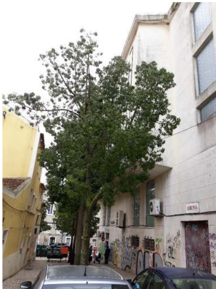
6 – Fachada lateral do edifício Cinema da AIRFA
