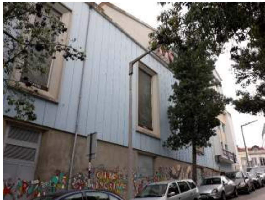
Fig. 5 – Fachada lateral Edifício Cine Incrível
