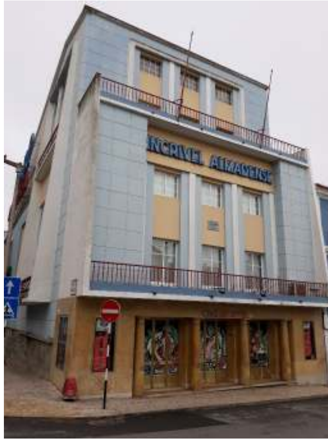
Fig. 4 – Fachada principal do Cine Incrível
