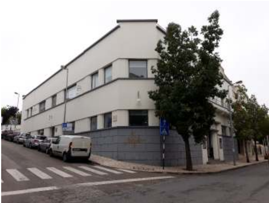
4 – Fachada lateral do edifício Cineteatro da AIRFA
