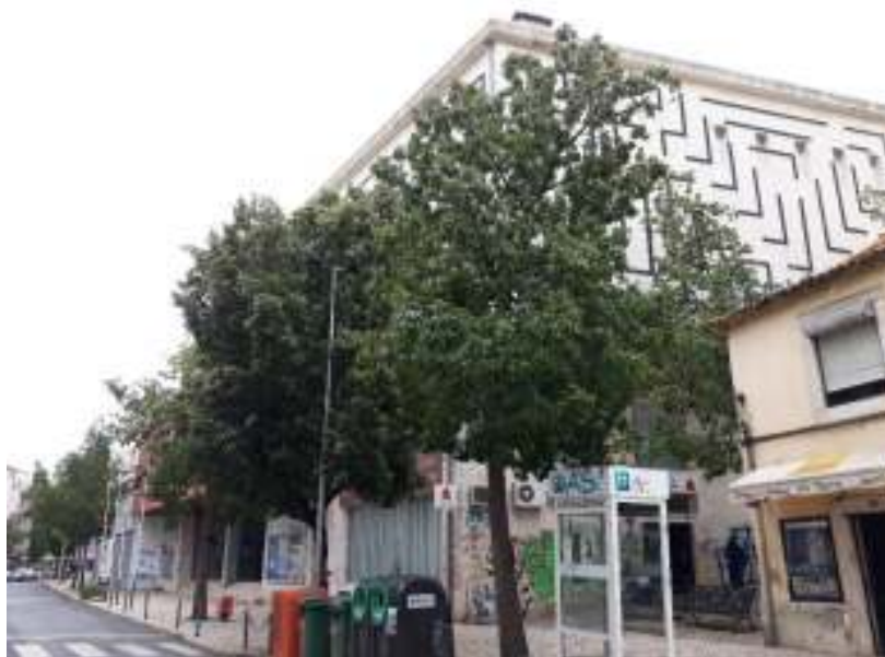
2- Rua Capitão Leitão – Edifício do Cinema e Cineteatro da AIRFA
