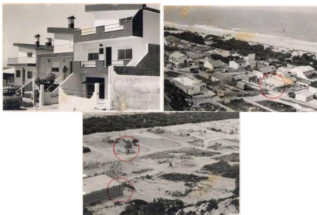
Figura 5 – Fotografias da época das demolições (antes e depois)
