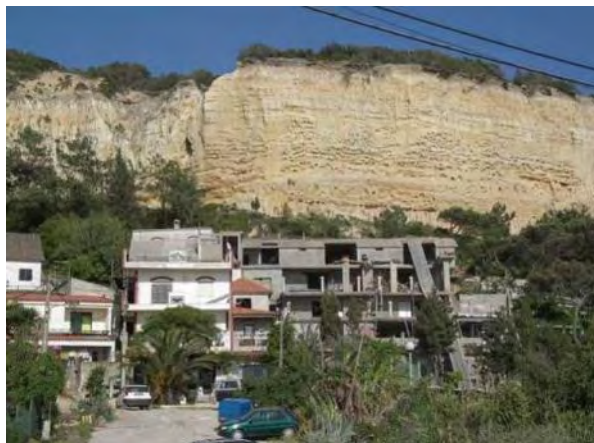
Figura 22 - Situação de risco eminente para as construções na proximidade da base da arriba
