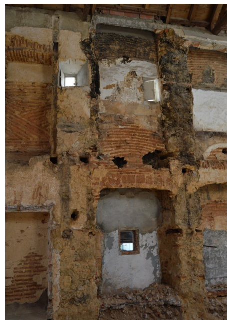
Chaminé do edifício do século XVIII
