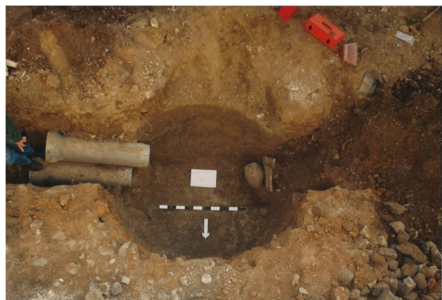
Base da cova de pão cortada pela obra de saneamento
