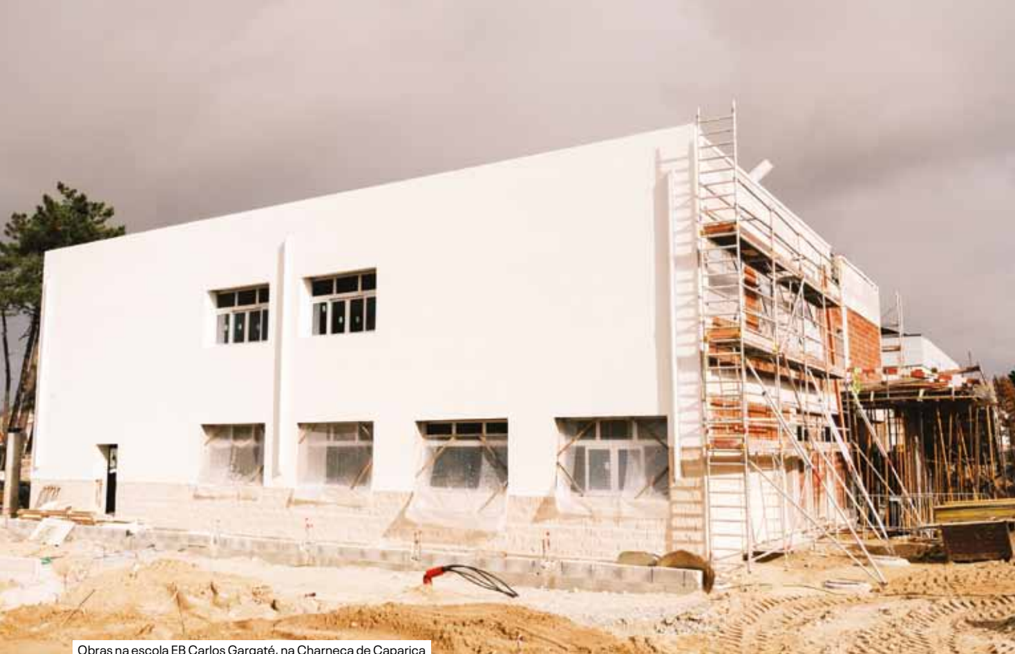
Obras na escola EB Carlos Gargaté, na Charneca de Caparica
