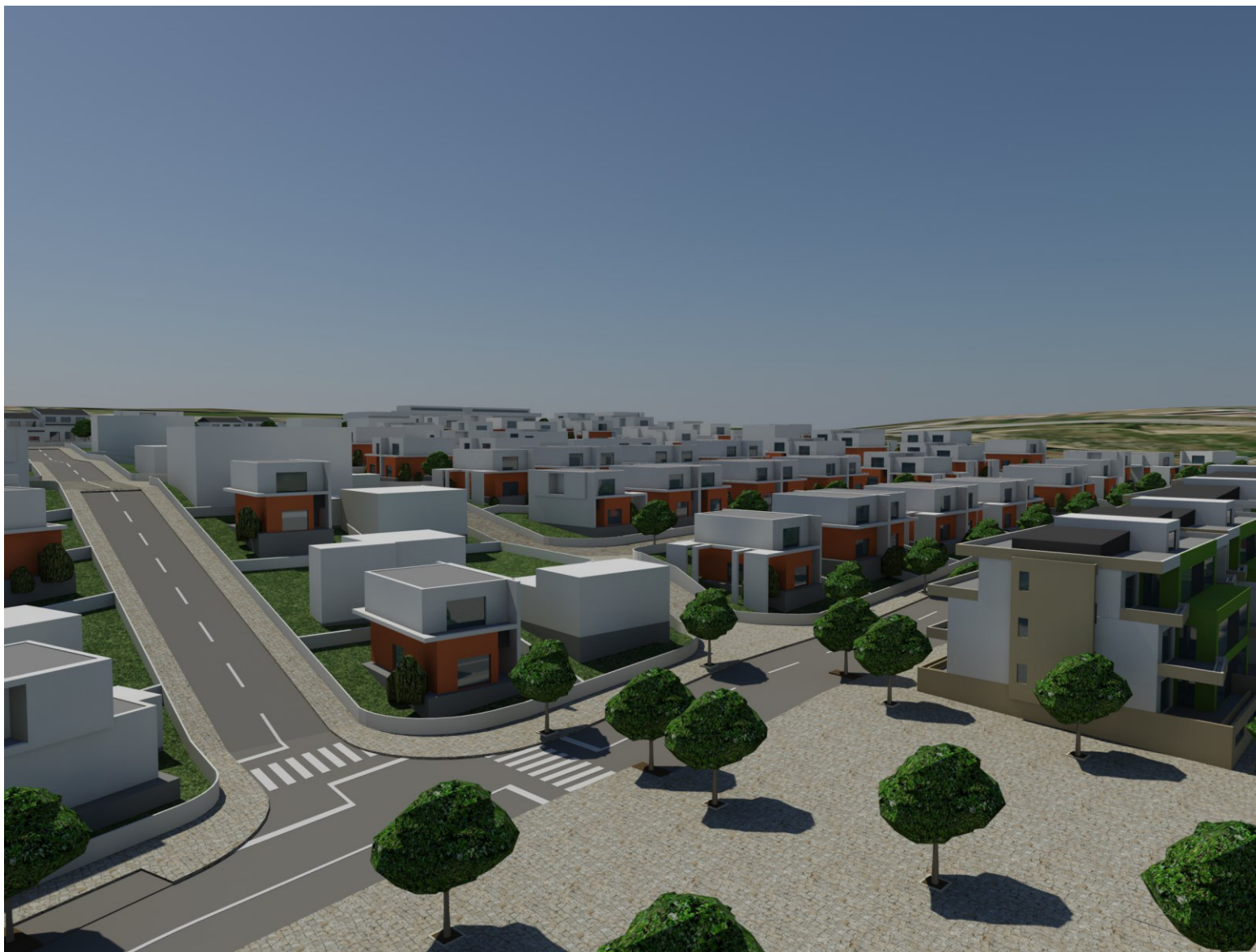
IMAGEM - 7 - Vista da Praceta e Polo 1 - A
