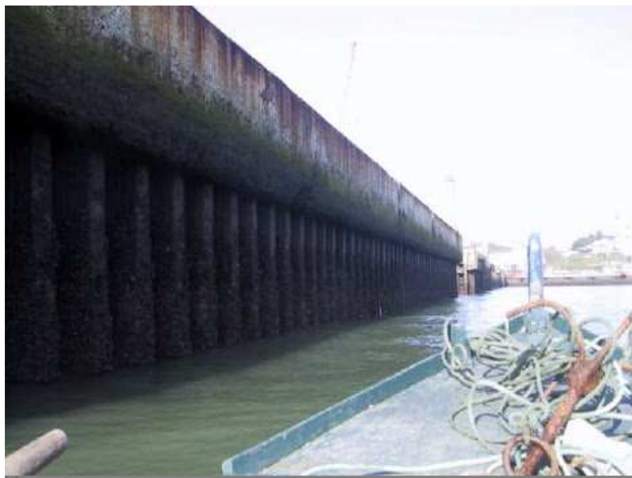
Fot. 17 – Retenção norte. Troço com infra-estrutura em cortina de estacas prancha
