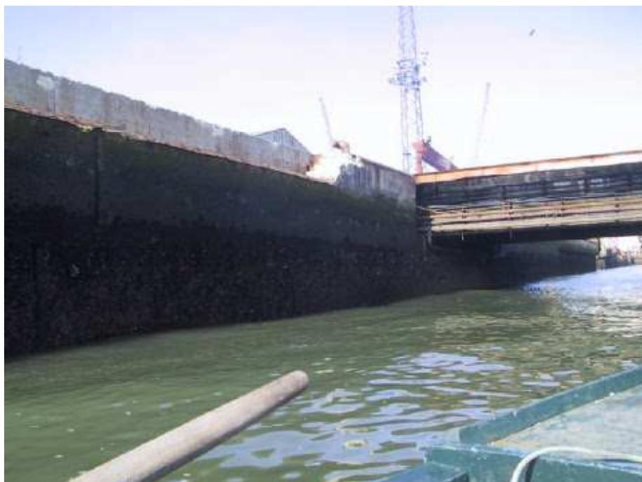
Fot. 16 – Retenção norte. Troço com infra-estrutura em blocos de betão
