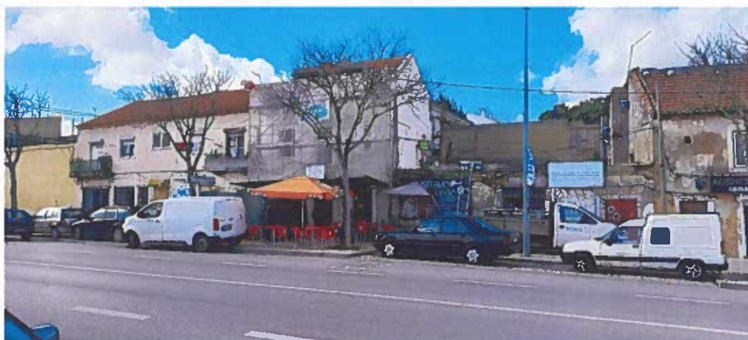
Rua Direita, n.ºs 40-42-44 (Obra a decorrer)
